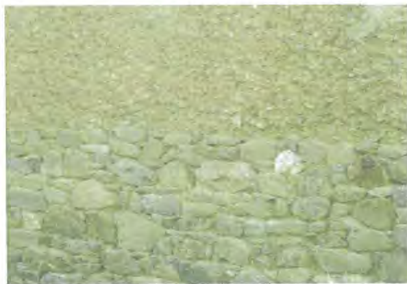
Construction mixte pierre et terre
