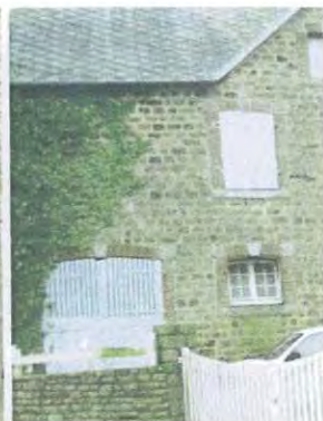
Linteau en arc surbaissé jambage en brique
