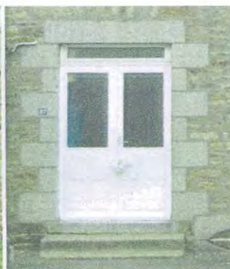
Linteaux droit monolithique jambage pierre de taille
