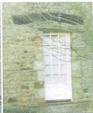
Linteaux en arc surbaissé jambage en PT et moellon
