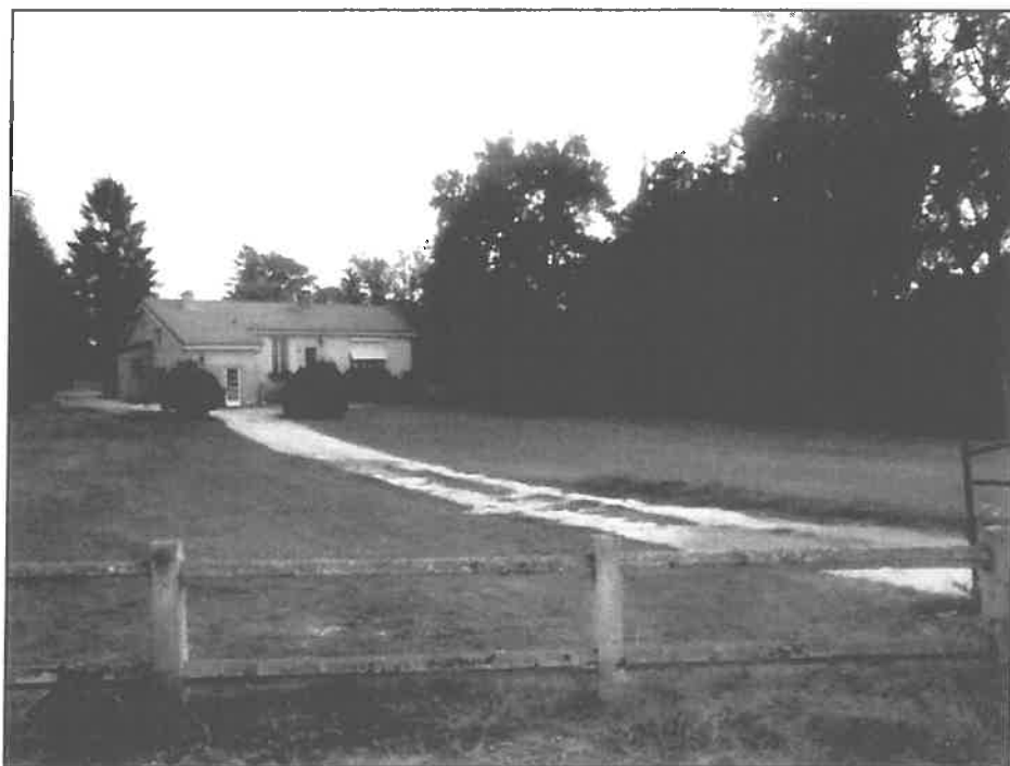
Pavillon situé en aval du captage
