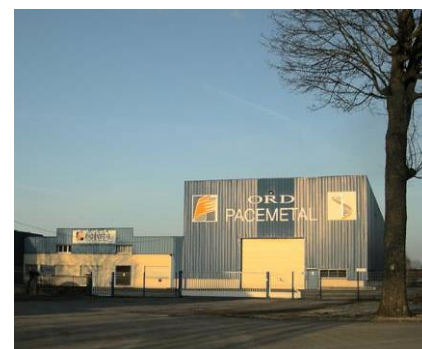
Bâtiment d'activités de forme cubique, aux couleurs vives
