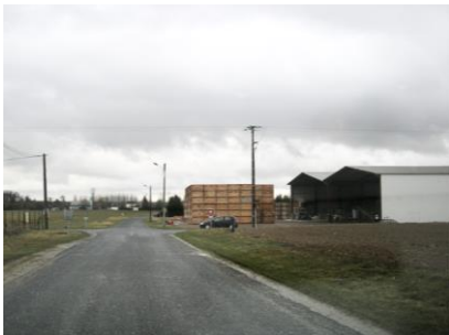
Présence d'un bâtiment d'activité qui marque l'embranchement de l'axe d'entrée de ville
