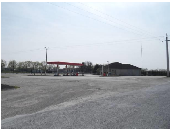
Vue 2 : la station-service et le bâtiment annexe
