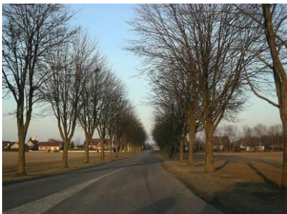
Axe d'entrée rectiligne accompagné d'un alignement d'arbres - tissu urbain visible de loin
