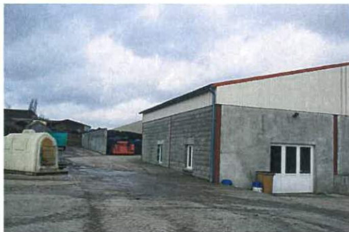
Bâtiment d'élevage Rue du Moulin
