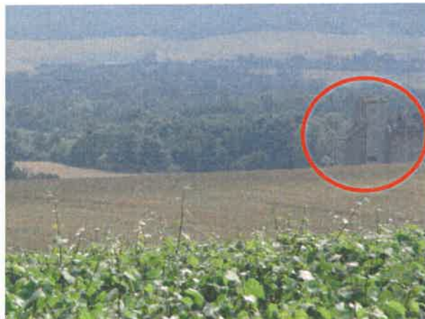
Le silo vu du Nord du territoire communal
