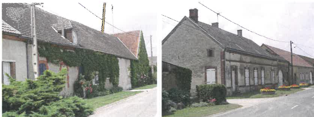
Un bâti aéré où le végétal est omni-présent
