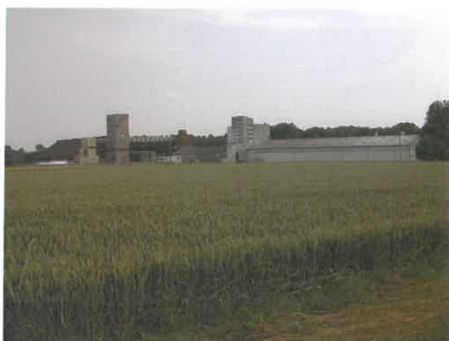
Bâtiment de stockage de granulats
