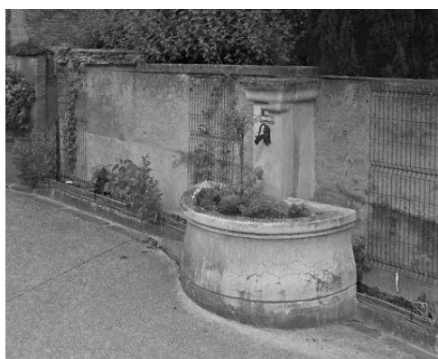
Fontaine communale située le long de la rue Principale – Place Neuve
