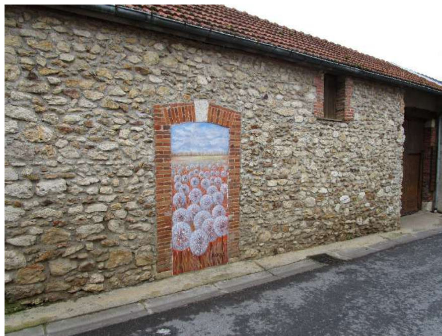
Figure 37 : bât en pierre calcaire grossière – centre-bourg
