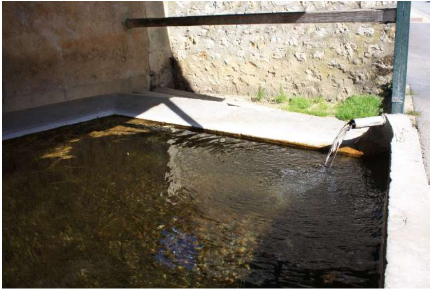
Figure 95 : bac du lavoir - Grande Rue
