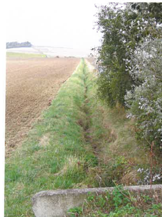
Fossé à la traversée de la RD 37
