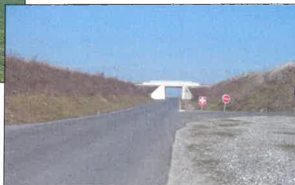
Pont de la LGV
