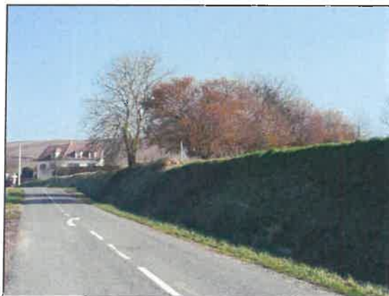
Talus le long de la RD 306
