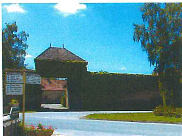
bâti sur la place du Général de Gaulle
