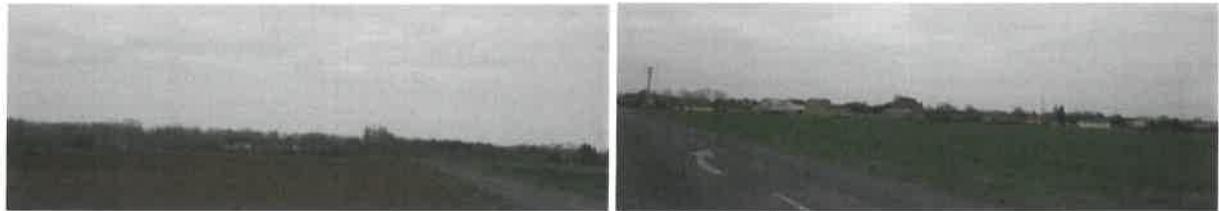
Vues prises depuis la route de Linthes, la RD205 et la RD53
