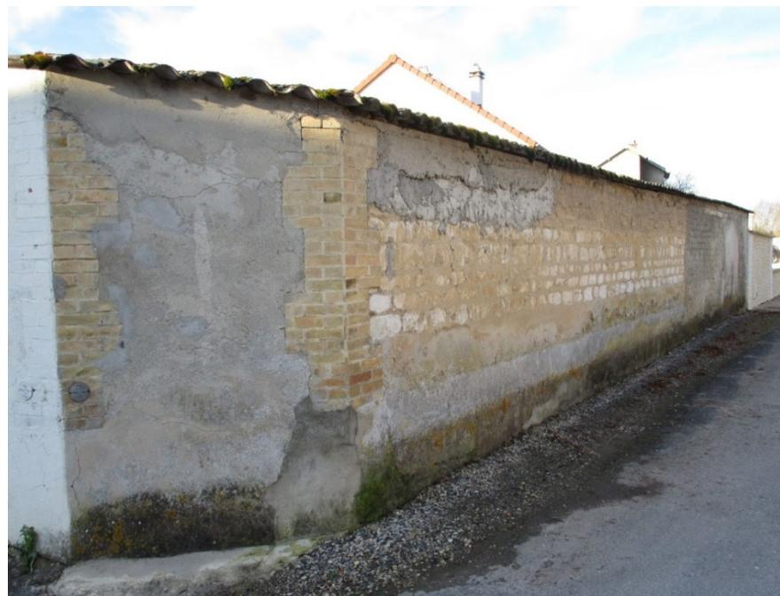
Figure 76 : suppression des linteaux sur la façade d'une maison à gauche
