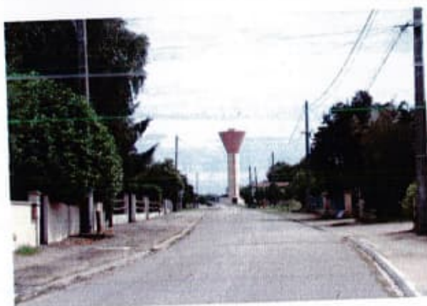
Le château d'eau
