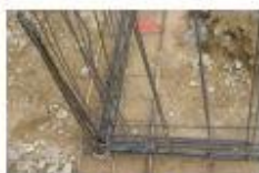
Nœud de chaînage - Continuité mécanique
