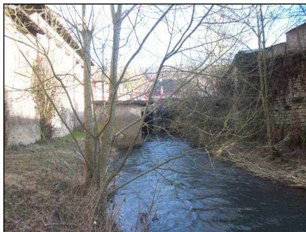
Entrée amont de la section recouverte au niveau du Pont de Moutier
