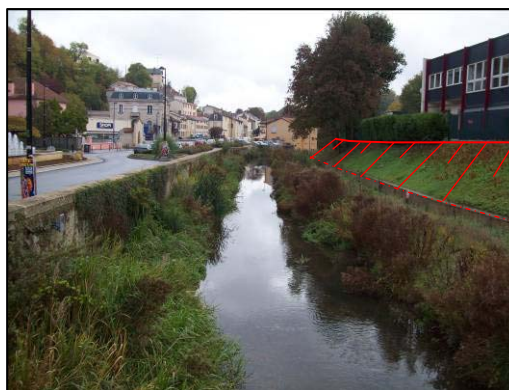
Remblai en rive droite dans la traversée de Briey
