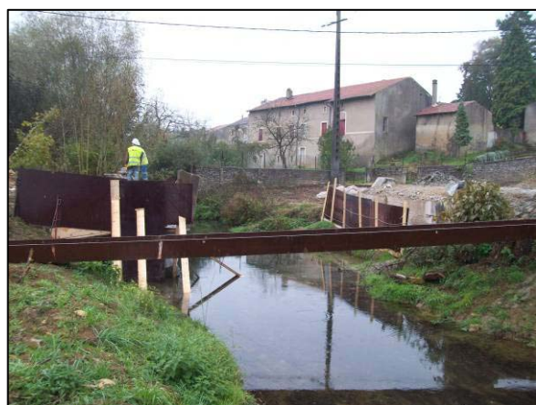
Construction du nouveau pont sur le Woigot à Mancieulles
