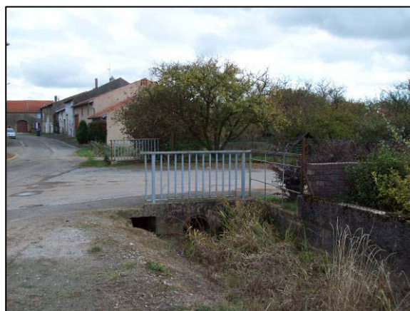
Ouvrages limitants sur le Woigot dans la traversée de Mairy-Mainville
