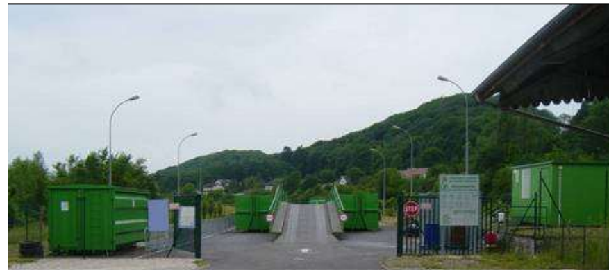
Photo 30 : La déchetterie rue de la Gare
