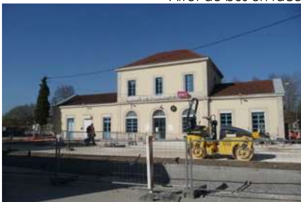
Gare de Commercy (travaux de réaménagement)
