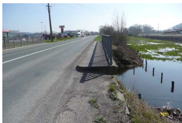
Pont sur la route d'Euville
