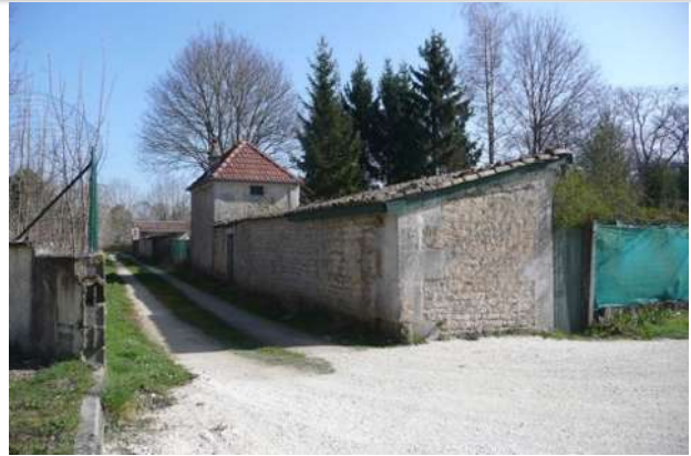
Mur à protéger rue du Dr Boyer
