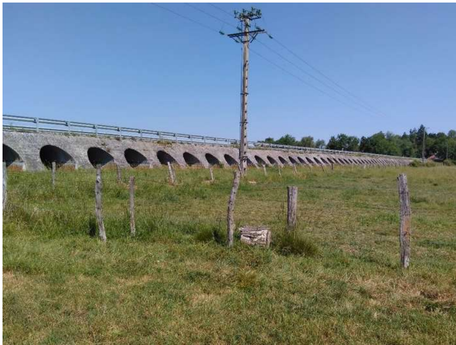
Vue des pâtures en vallée inondable et de l'ouvrage de transparence hydraulique
