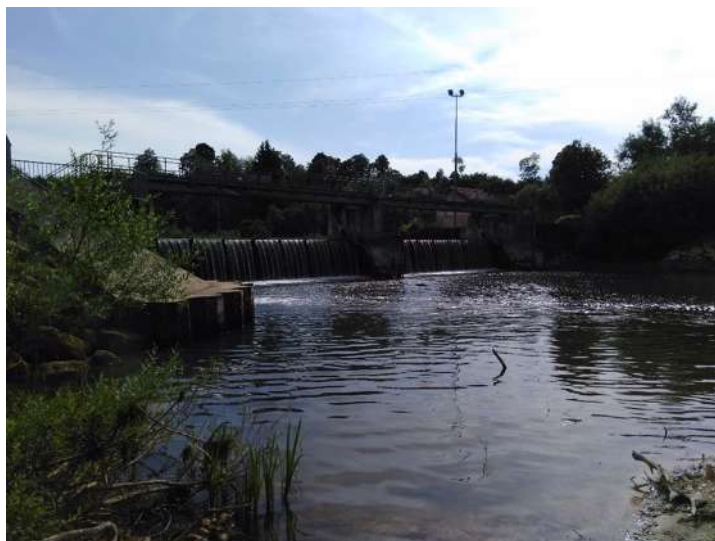
La Meuse dérivée en aval du canal
