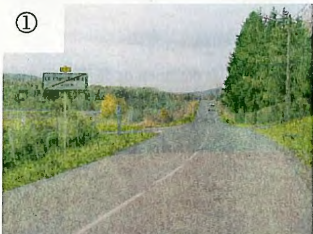
Sortie de la Contrôlerie vers les Islettes : pont sur l'autoroute.
