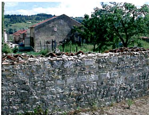
Muret couvert de tuiles canal
