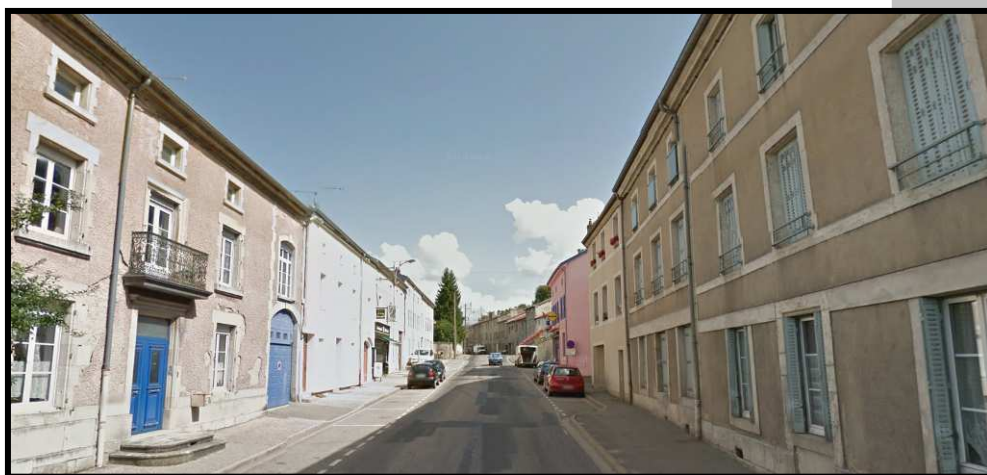
RD964 : hauteurs des bâtiments plus importantes, implantation de commerces et services marquant la façade par une vitrine ou une enseigne, proportion des ouvertures globalement conservée ainsi que les alignements des façades et des toitures
