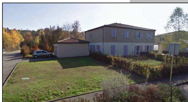
Logements rue de la Libération
