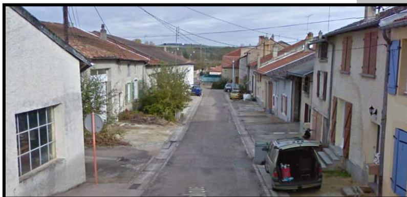
Rue de la République : petits usoirs, légers décrochements de façade, décrochement de toitures, toiture de couleur rouge vieilli, ouvertures plus hautes que larges, volets bois....
