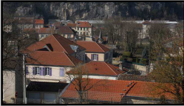
Mairie, rue du Dr Vauthier et rue de la Libération : harmonie des volumes, des toitures et des ouvertures en façades.
