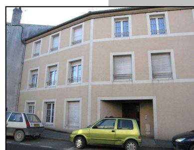
Logements 30 rue nationale, OPH Meuse
