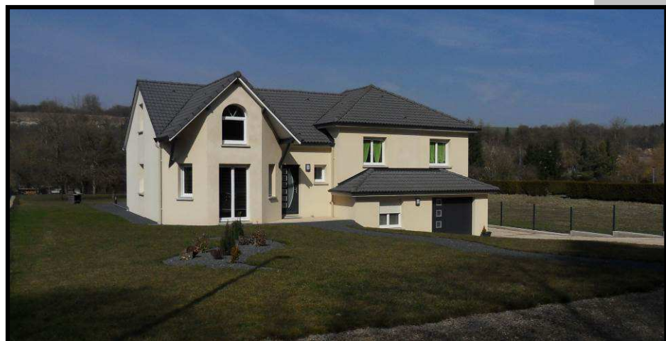
Rue de Buez : construction récente : toiture noire et multipans, sous-sol semi-enterré, recul important par rapport à la voirie
