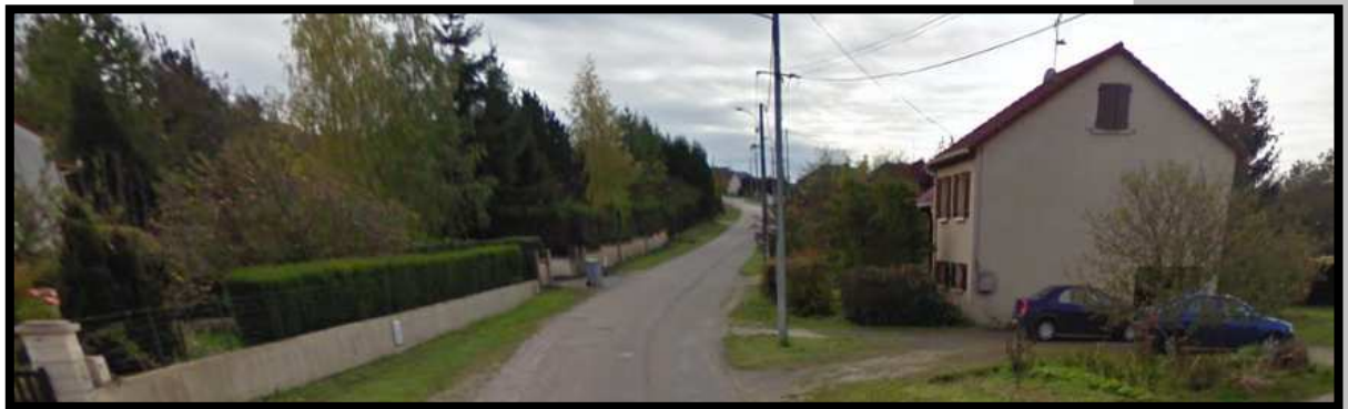
Rue du 154 ème RI: Travaux prévus pour 2017 : enfouissement des réseaux, création d'un espace partagé piéton-voiture avec maintien d'un côté vert, zone 30 avec 3 passages surélevés
