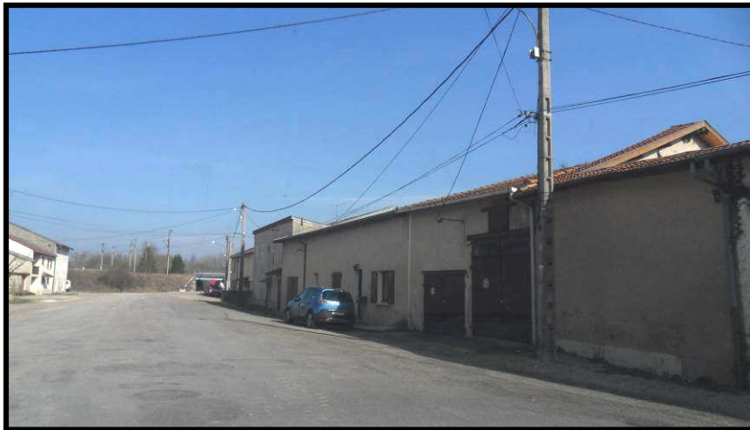
Place E.Level : alignement des façades, décrochement de toiture, porte linteau droit
