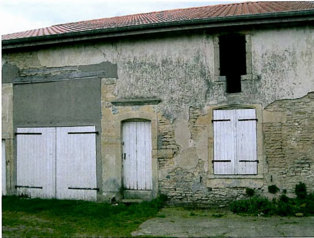
photo n° 7: ancienne ferme, avec une ouverture ajoutée à l'étage au XIX ou XXe siècle.
