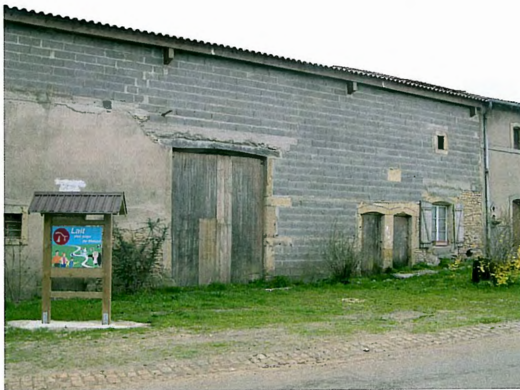
photo n° 8: bâtiment partiellement rénové
