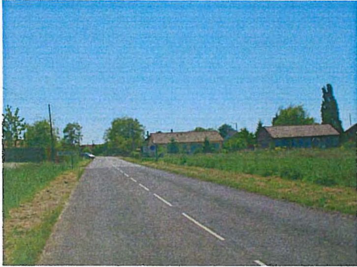
La RD 122 reliant NEUVILLE à VASSINCOURT
