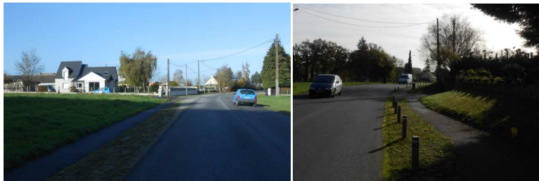
Un exemple de cheminement réalisé le long de la RD 13
