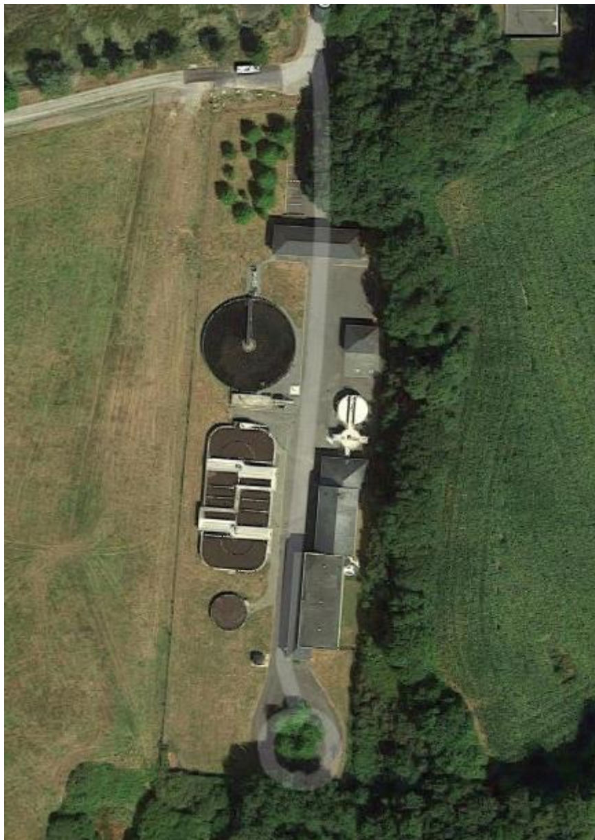
Figure 22 : station d'épuration d'Hennebont Source : Orthophoto - 2016
