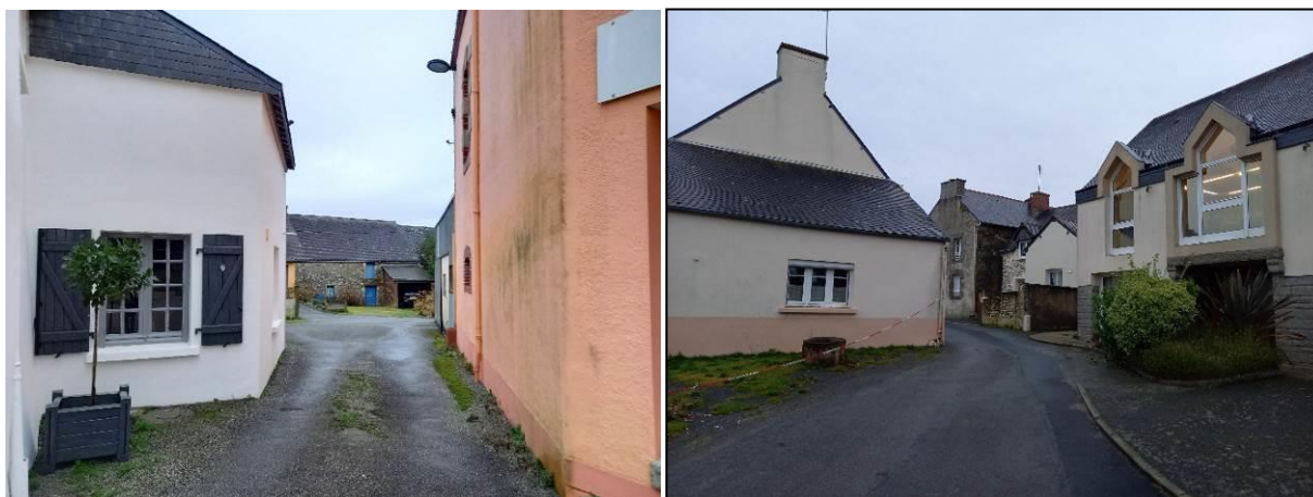
Voies tertiaires très étroites : rue Quartier Saint-Martin et rue du Paradis
