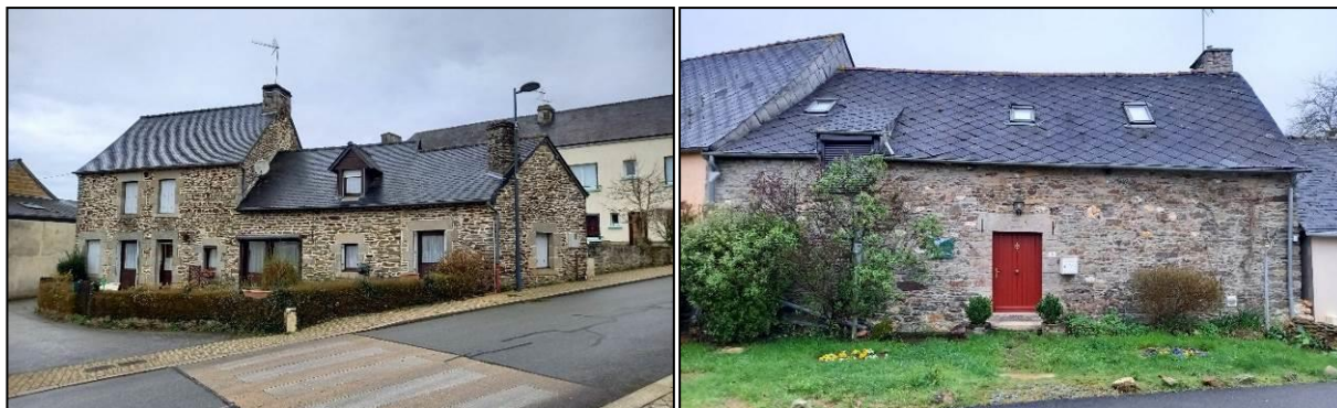
Bâtis longères en pierres
