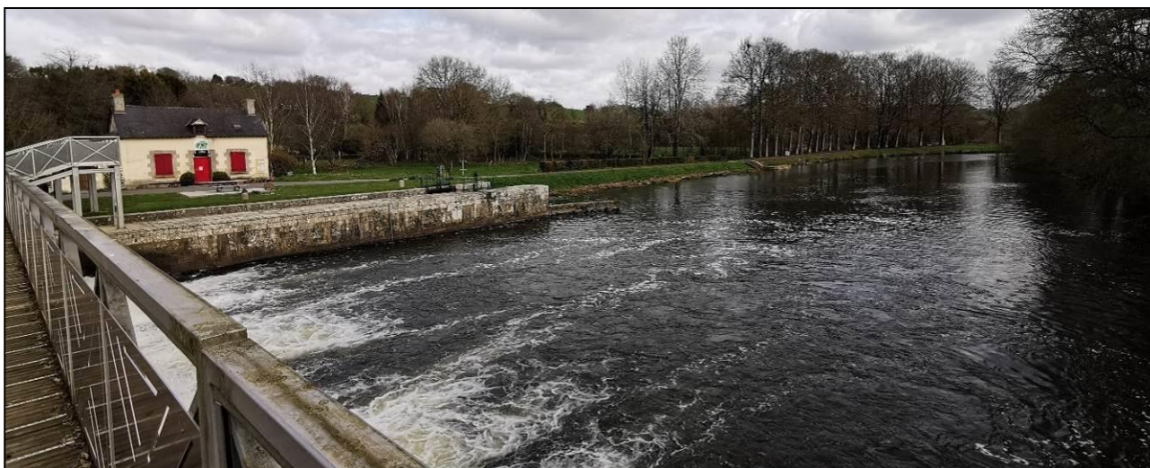
Écluse et passerelle du Rouvray
