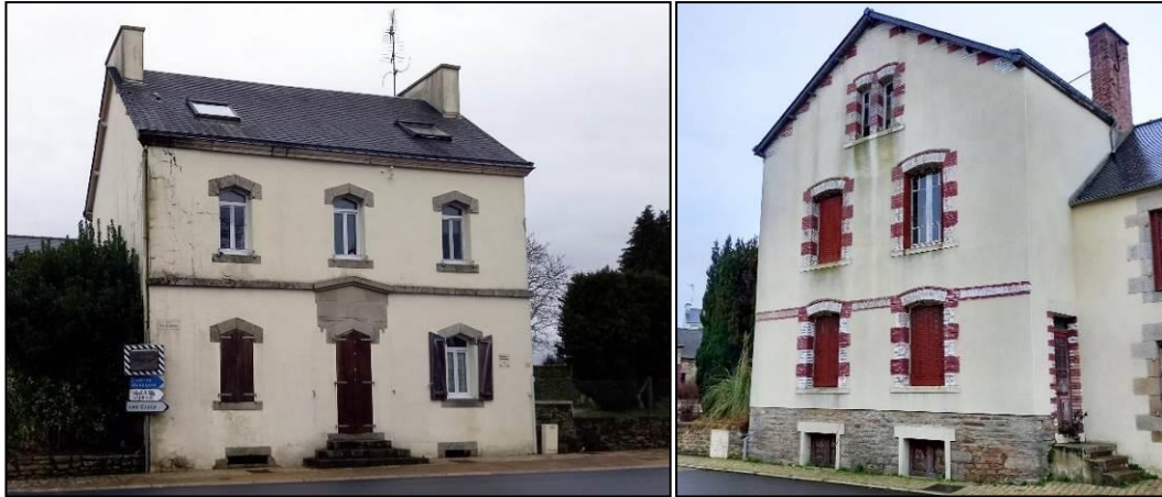
Toitures à deux pans : ancienne école de 1877 à gauche
