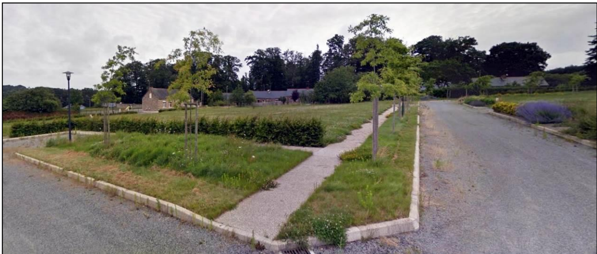
Lotissement, voie de faible largeur et cheminements piétons sécurisés en stabilisé
