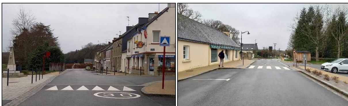
Zone 30 et plateau surélevé et amélioration des cheminements piétons
