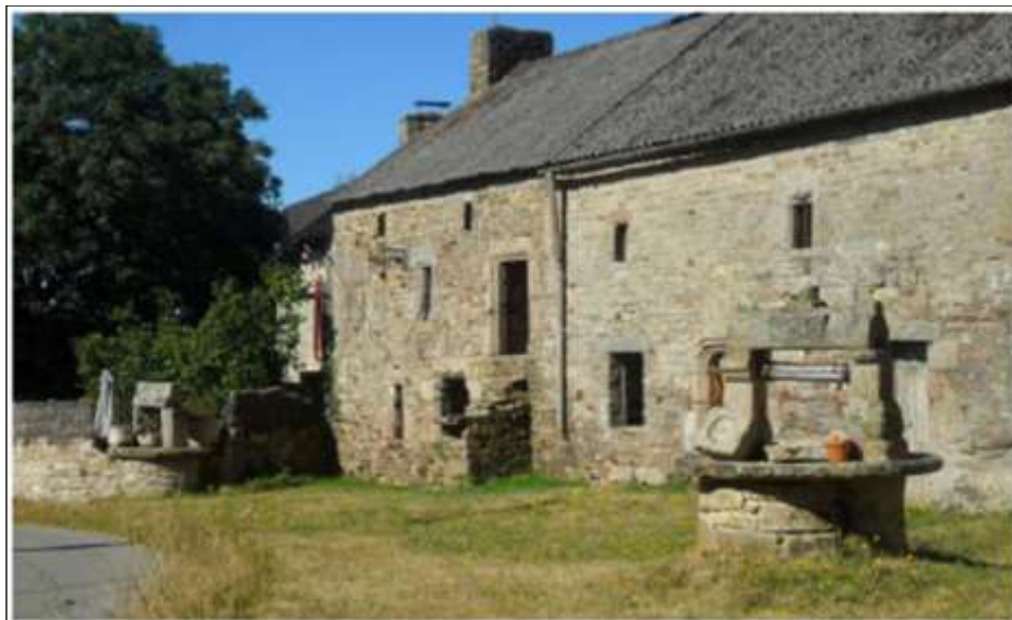
Perenno-lhuel / Bâtiments remarquables dans le hameau
