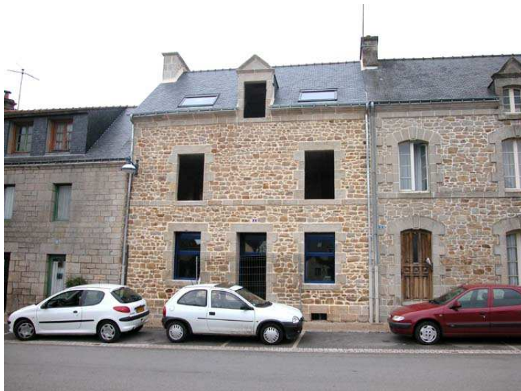
Futur emplacement du bureau de poste sur la place du marché
