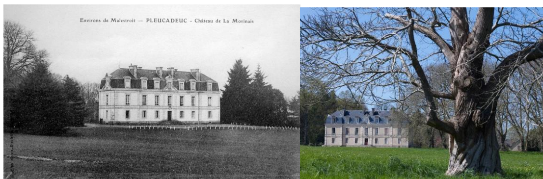
Figure 46 : Château de la Morinais (Source : Glad, patrimoine.bzh, inventaire de la Région Bretagne)
