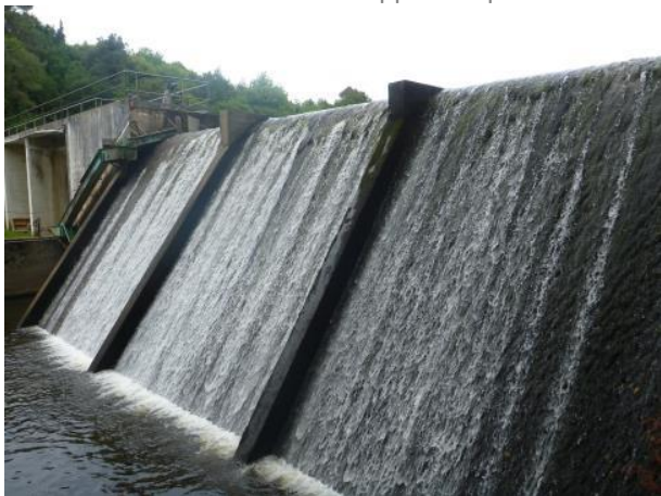
Photo 1 : Barrage de Pont Sal - supprimé
