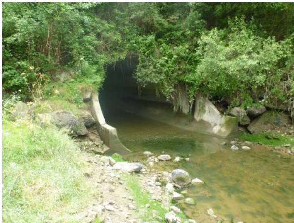
Photo 2 : Tunnel sous la RN165
