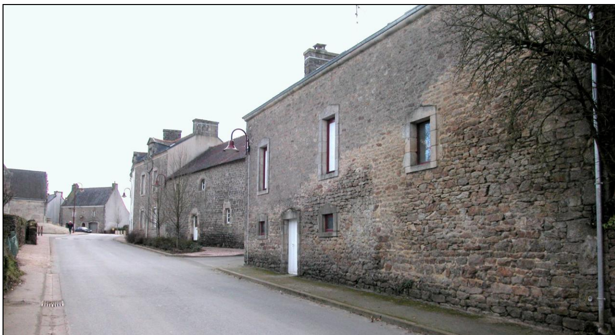
Urbanisation dense et ancienne du centre bourg
