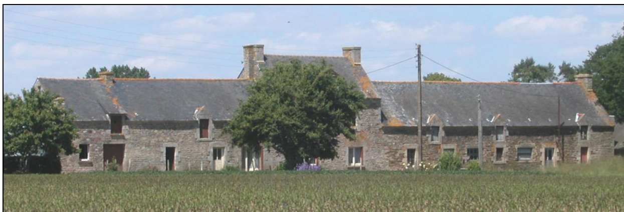
Exemple de bâtiment pouvant bénéficier du zonage Nr
