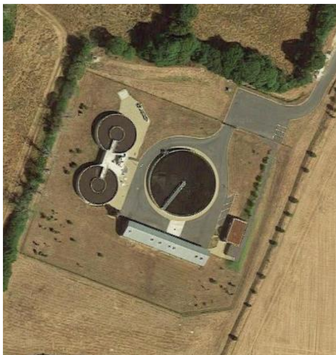
Figure 29 : station d'épuration intercommunale -Source : Orthophoto - 2016
