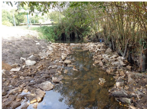
Abaissement de seuil par enrochement du Riant
