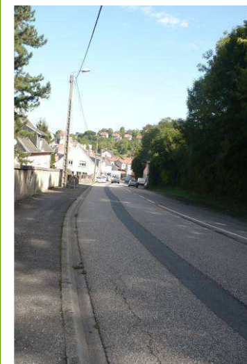
RD654 – Entrée Sud
