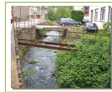
Ruisseau de Manderen canalisé, APACH – rue de la Gare
