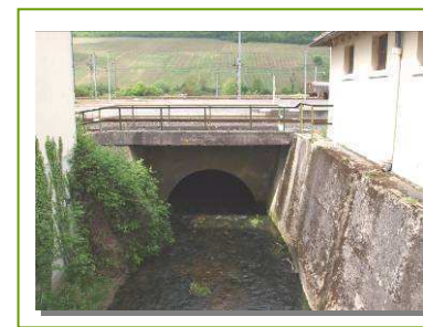
Ruisseau de Manderen passant sous les voies de chemin de fer avant de se jeter dans la Moselle
