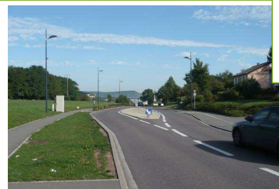
RD654 - Aménagements entrée Nord
