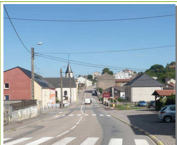
Exemple d'espaces artificialisés : Les voies routières
