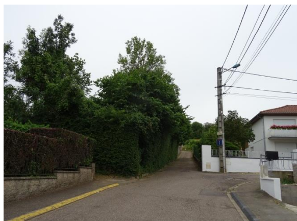
Photographie depuis la voirie du réseau électrique
