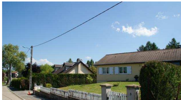
Toitures à pentes faibles (1 er plan) et à pentes plus importantes (2 nd plan)
