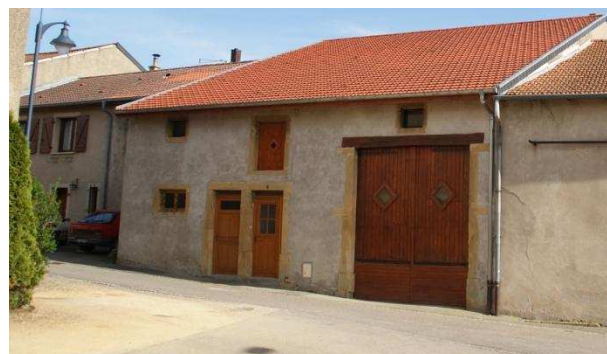
Linteaux droits sur la porte du garage
