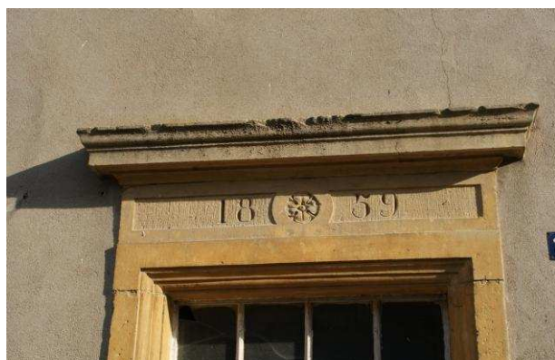
Détail : date + corniche sur porte d'entrée
