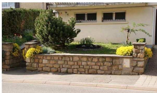
Clôture basse avec muret bas en pierre
