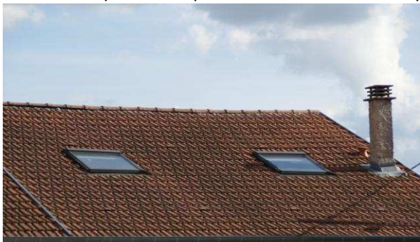
Pente faible – Teinte orangée – Fenêtre de toit
