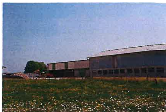
Bâtiment d'élevage - rue Hofgasse -
