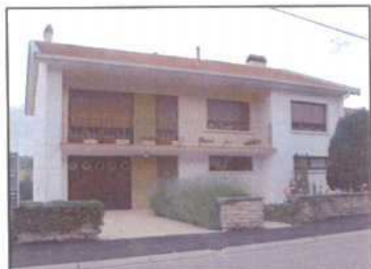
Pavillon, années 70-80 rue du Queulot, Faily
