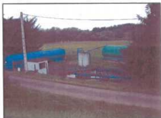
Station d'épuration entrée Ouest de Faily
