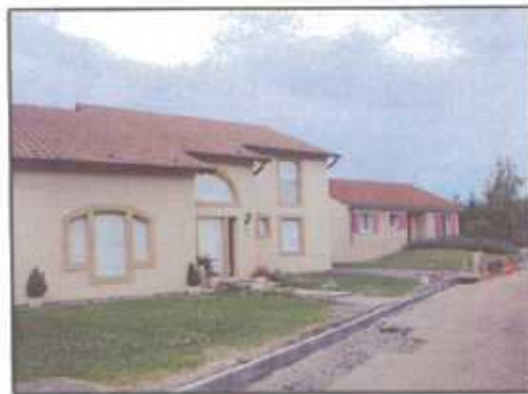
Pavillons, années 2000 rue du 19 mars 1962, Faily
