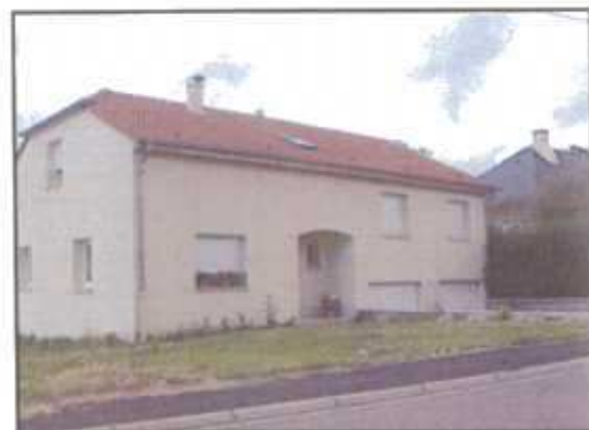
Pavillon, années 2000 rue du Queulot, Faily
