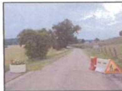
Sortie de village Faily voie communale de Vrémy à Faily
