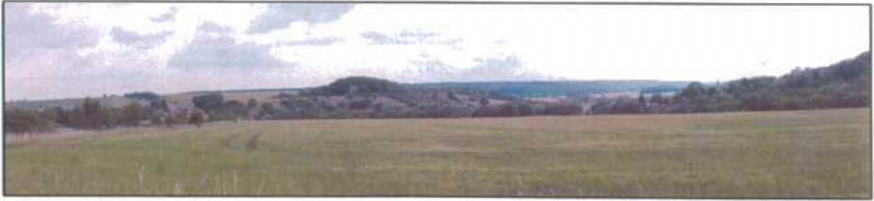
Vue sur la frange Ouest du territoire : A.4, vestige de l'ancien viaduc, vallon et village de Fally (de gauche à droite)
