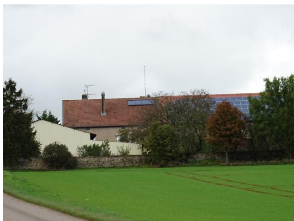
Panneaux solaires, Route de Jarny
