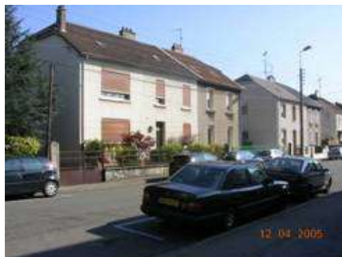
- Rue du Docteur Zamenhof - Maisons jumelées présentant une homogénéité par la répétition des formes. Cette typologie est proche de celle de la cité (malgré l'existence de baies en façades)
