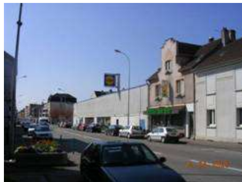
- Rue de Metz - Une supérette de proximité vient déstructurer la rue qui présente déjà de nombreuses variations de formes, volumes, hauteurs correspondant à la succession des époques de construction. Ce commerce est monolithique, sans percement et habillé d'un bardage métallique peint.
