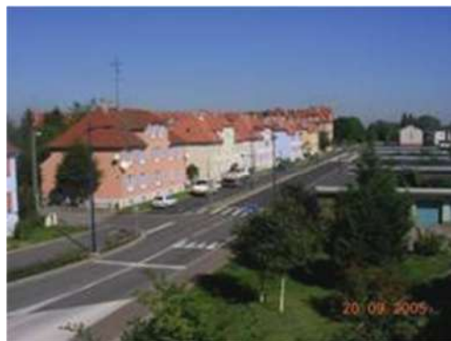
- Cité Thyssen - Immeubles collectifs locatifs, rue Wilson. Une opération d'amélioration de la qualité du bâti : ravalement de façade, création d'une contre-allée, traitement des abords, mise aux normes sanitaires.
