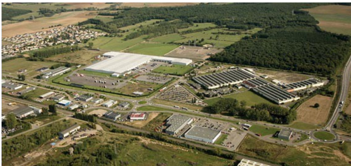
Vue aérienne de la Zac du Kickelsberg – Source : Sodevam.
