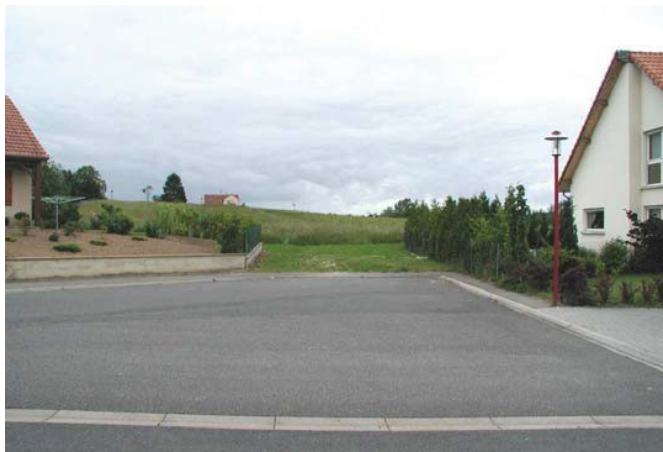
Amorce de voie en attente au lotissement du Tal
