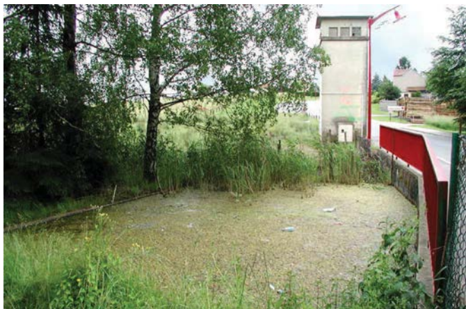
Bassin de décantation d'un affluent du Hoppbach
