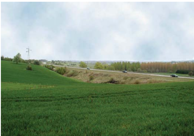
Le talus de la N 61 isole la zone de loisirs du village
