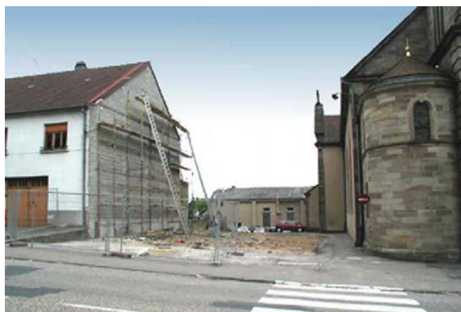
Passage latéral de l'église, en cours d'élargissement
