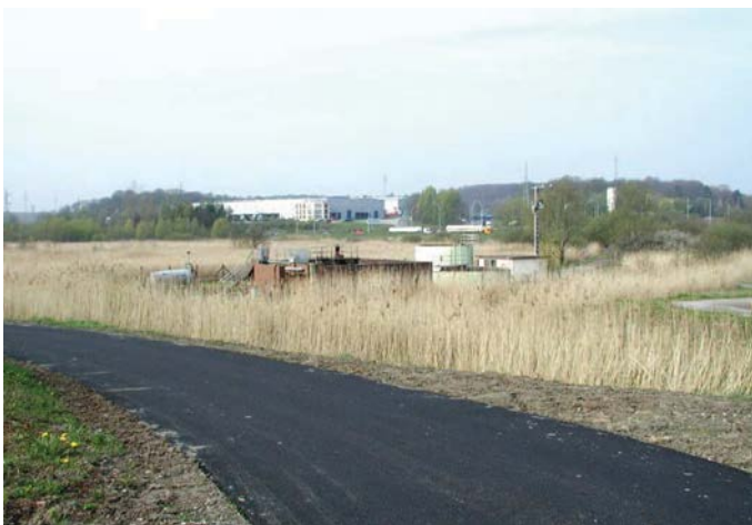
La station d'épuration, dans la roselière de l'Europôle
