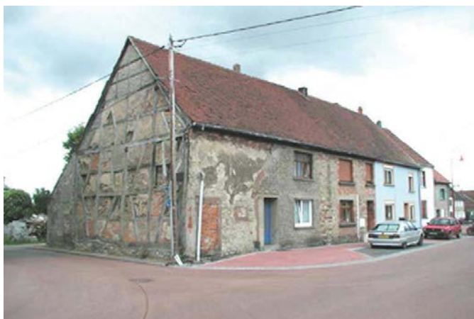
Ancienne maison à pan de bois, dont les colombages ont disparu lors de sa rénovation
