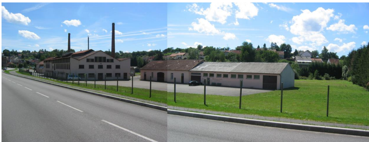
Aperçu du site de la cristallerie depuis la RD 96
