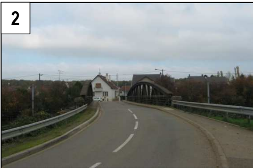
2 Passage supérieur rue des Ponts. La largeur du pont permet la circulation à double sens. Présence de trottoirs étroits des deux côtés de la voirie.
