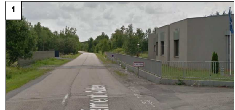
Entrée de village, rue des Ponts par la ZAC Actypôle
