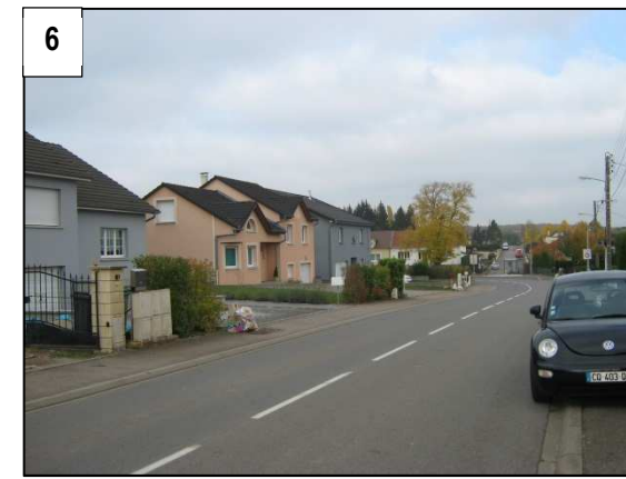
6 Rue de Kuntzig, trottoirs des deux côtés de la voirie
