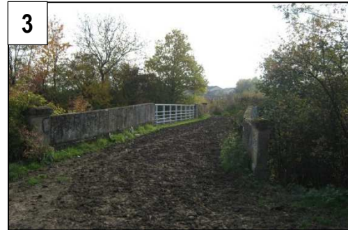
3 Pont qui sert au passage des bêtes d'élevage et aux engins agricoles. Ce passage s'insère dans le réseau de
