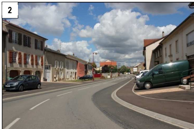
2 D118a, route principale du village avec stationnement des particuliers sur les usoirs et séparés de la voirie par un trottoir
