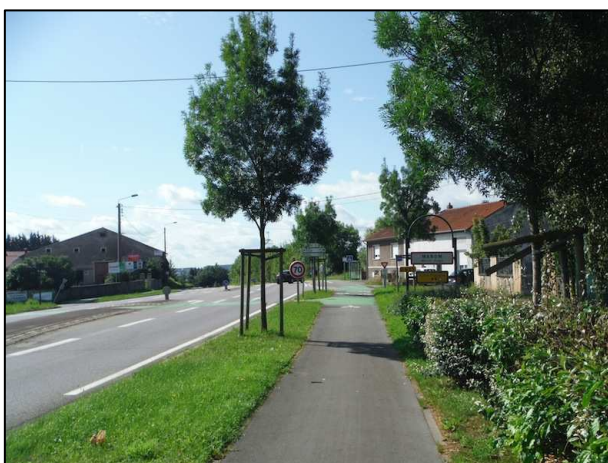
Vue sur l'entrée d'agglomération Nord de Maison Rouge, avec une vitesse limitée à 70km/h sur la R.D.653
