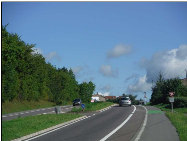
Vue sur la R.D.653 et la piste cyclable dans la traversée de Maison Rouge
