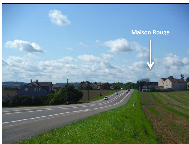
Vue sur la R.D.653 en entrée d'agglomération depuis Hettange-Grande
