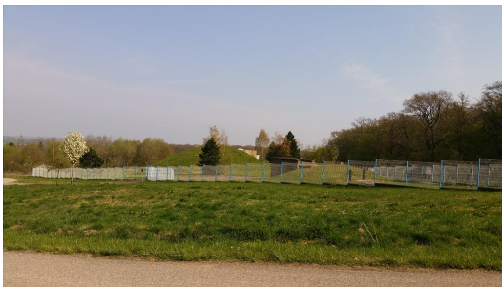
Réservoir d'eau potable
