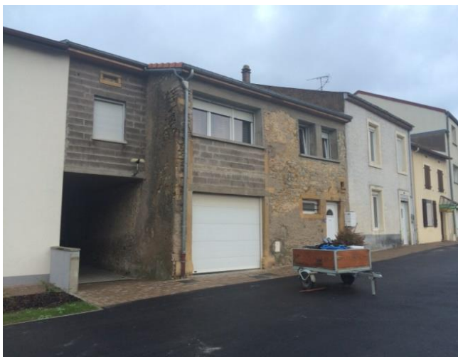
Opération de rénovation d'habitat du centre-village
