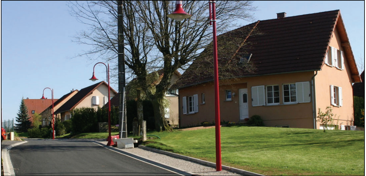
Rue des Carrières récemment rénovée
