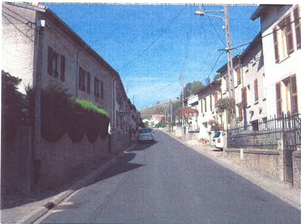
Développement urbanisé le long de la rue Raide Cote
