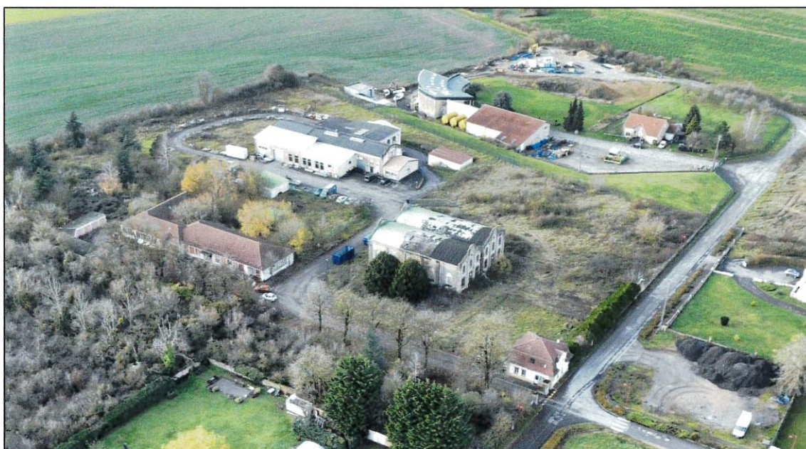
Vue aérienne d'une partie de la friche du Carreau de la mine et des activités présentes à proximité.
