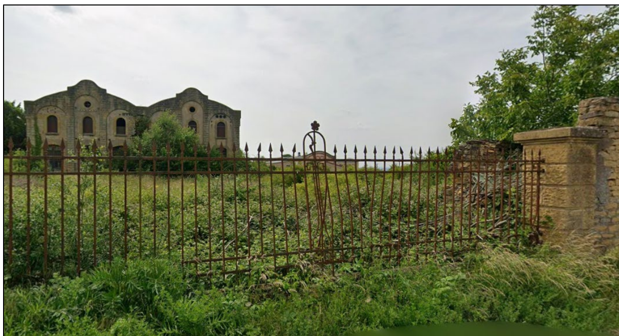
Etat actuel de la friche du Carreau de la Mine vue du Chemin de l'Exhaure
